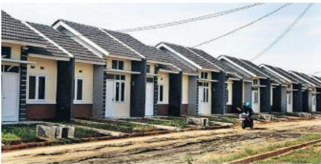
Barisan melintas di proyek pembangunan rumah bersubsidi di Kliparengkul, Kabupaten Bojonegara, belum lama ini.
