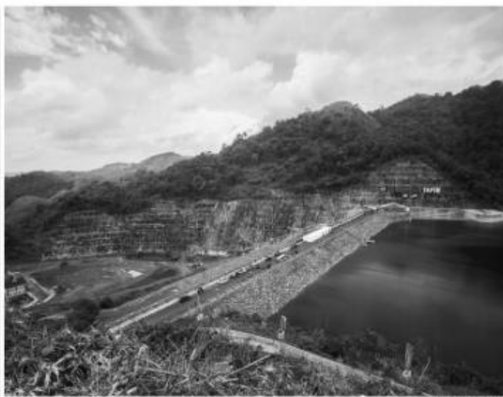
Foto aerial kawasan Bendungan Tapin di Desa Pipitak Jaya, Kabupaten Tapin, Kalimantan Selatan, Kamis (18/2/2021). Bendungan yang diresmikan Presiden Joko Widodo ini dimanfaatkan, antara lain, untuk irigasi 5.472 hektar lahan pertanian, pembangkit listrik tenaga air berkapasitas 3,3 megawatt, pengendali banjir, dan menjadi obyek wisata bagi masyarakat.
