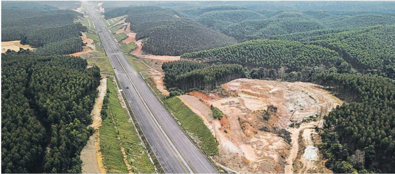
Jalan Tol Pekanbaru-Dumai, Riau, diabadikan dari ketinggian, Sabtu (26/9). Tol sepanjang 131,5 kilometer dengan investasi senilai Rp12,18 triliun tersebut saat ini sudah dapat dilalui secara gratis sembari menunggu penetapan tarif yang akan diberlakukan.
