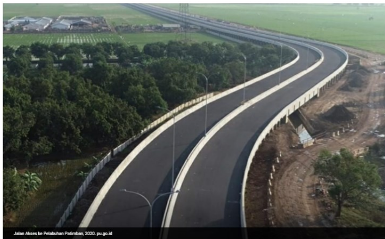
Jalan Akses ke Pelabuhan Patimban, 2020. pu.go.id
