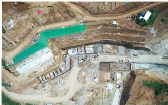
Proses pembangunan Bendungan Ciawi (Cipayung), Jawa Barat.
