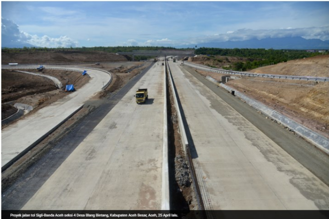
Proyek jalan tol Sigli-Banda Aceh seksi 4 Desa Blang Bintang, Kabupaten Aceh Besar, Aceh, 25 April lalu.
