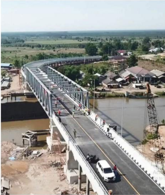
JEMBATAN KANAL ANTANG: Warga melakukan aktivitas di Jembatan Kanal Antang di Sungai Puting, Kabupaten Tapin, Kalimantan Selatan, yang diresmikan Menteri PU-Pera Basuki Hadimuljono, Sabtu (8/2). Keberadaan jembatan yang dibangun melalui dana CSR perusahaan PT Antang Gunung Meratus (AGM) senilai Rp66,5 miliar tersebut diharapkan mampu membuka akses dan mendorong ekonomi masyarakat pinggiran di Kalsel.
