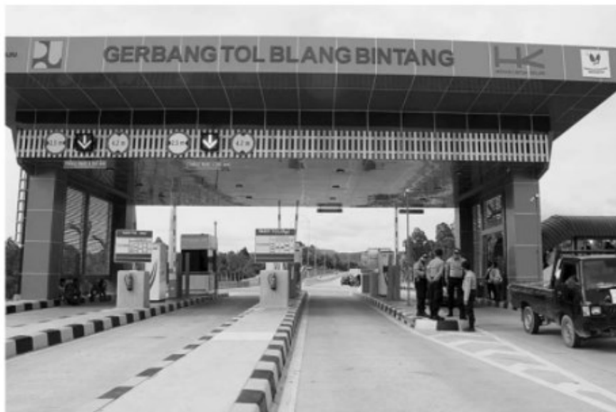
Jalan Tol Trans-Sumatera seksi IV sepanjang 13,5 kilometer dari Blang Bintang-Indrapuri, Kabupaten Aceh Besar, Provinsi Aceh, rampung seperti terlihat pada Senin, (24/8/2020). Jalan tol seksi IV itu akan dibuka untuk umum setelah diresmikan Presiden Joko Widodo yang dijadwalkan pada Selasa (25/8/2020) ini. Ruas ini bagian dari pembangunan Tol Banda Aceh-Sigli sepanjang 74 km. PT Hutama Karya menargetkan Tol Banda Aceh-Sigli beroperasi pada akhir 2021.
