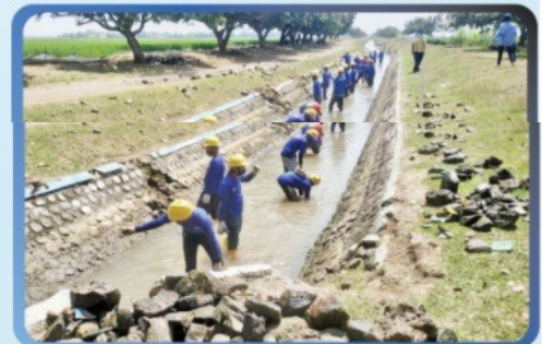
Kegiatan kontraktual yang dipadatkaryakan: Pembangunan Saluran Irigasi Tersier
