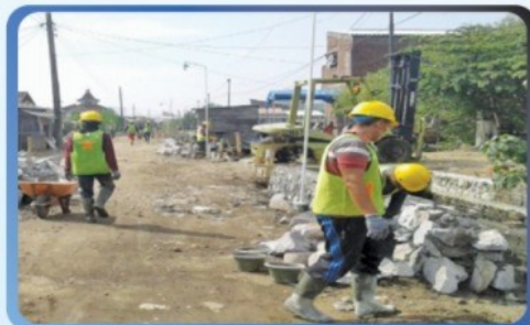
Pembangunan drainase kegiatan KOTAKU
