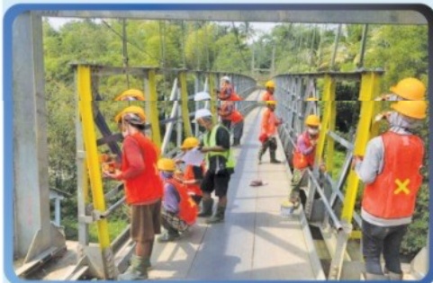
Pengecatan jembatan gantung
