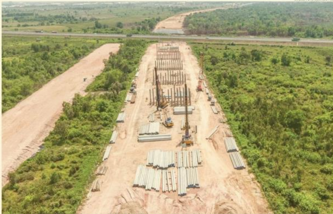
Foto udara pembangunan simpang susun antara jalan tol Sumatera ruas Kayu Agung-Palembang-Betung (Kapal Betung) dan jalan tol Sumatera ruas Palembang-Indralaya (Palindra) di Desa Ibul Besar I, Pemulutan, Ogan Ilir, Sumatera Selatan, Kamis pekan lalu.
