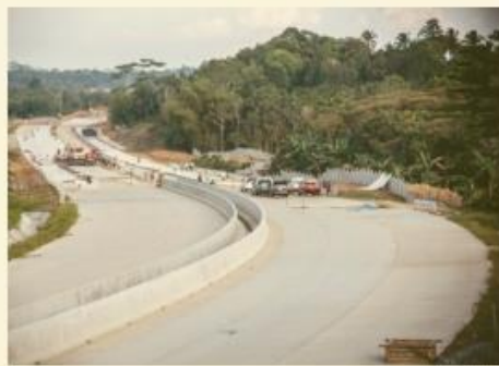
JALAN TOL: Suasana Proyek Pembangunan ruas jalan Tol Balikpapan-Samarinda (MPC) Sekeloa V rute Km 13-SPN bagian di Balikpapan, Kalimantan Timur, Jumat (7/9). Pembangunan ruas jalan Tol Balikpapan-Samarinda bagian dari Proyek Strategis Nasional sepanjang kurang lebih 99 kilometer yang terbagi dalam lima seksi itu ditargetkan selesai pada April 2019.
