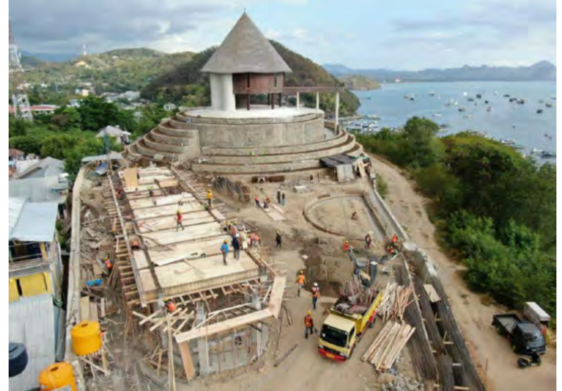
Pembangunan Infrastruktur untuk KSPN Labuan Bajo
