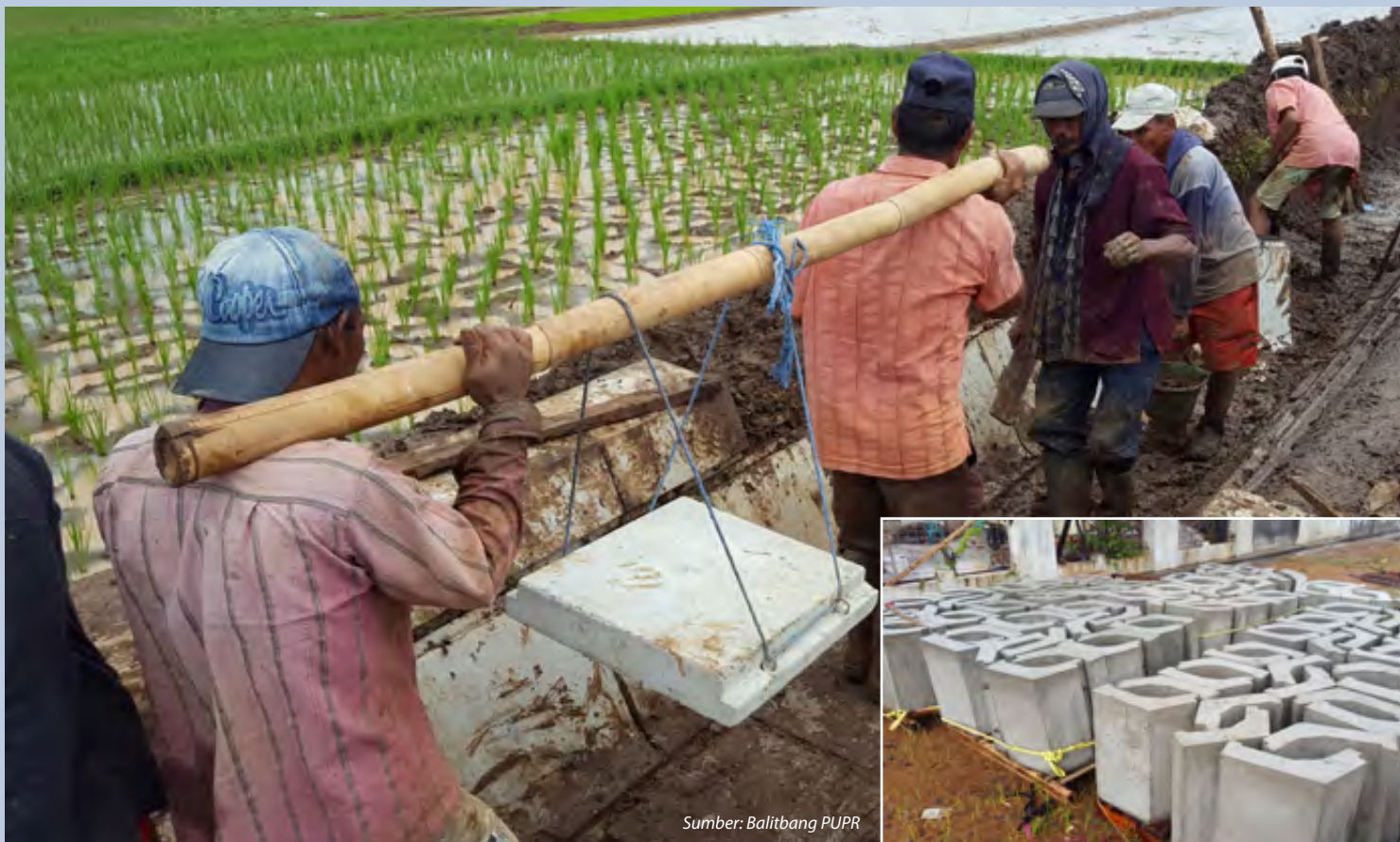
Proses pengangkatan modul dengan alat sederhana
