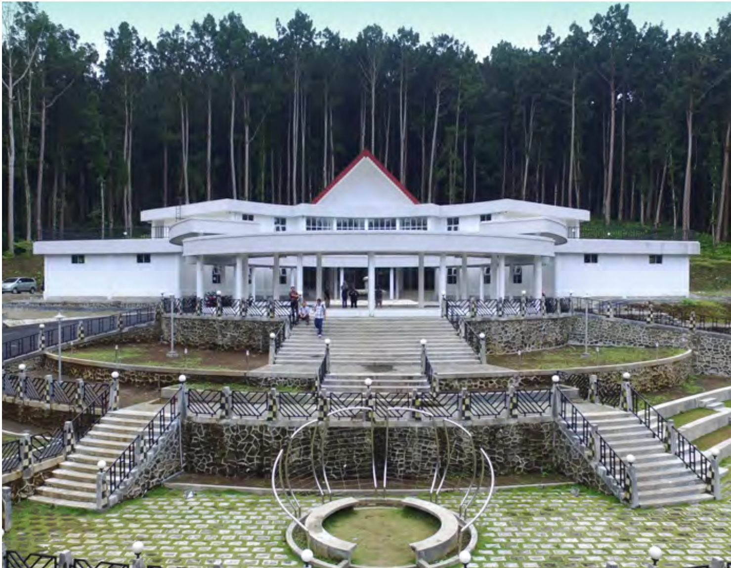
Bangunan Pendukung Kebun Raya Baturraden
