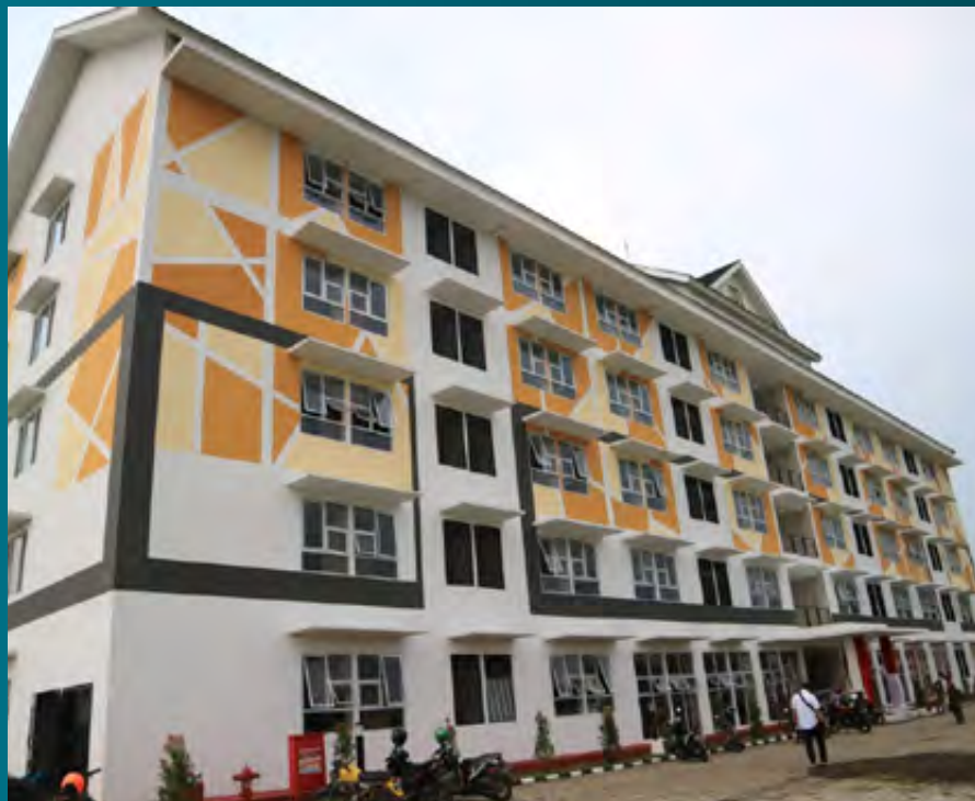
Rusunawa Tembok Rejo
