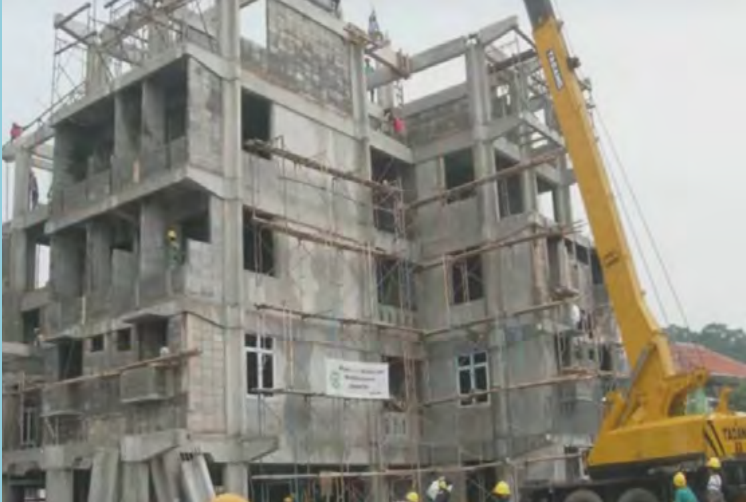
Gambar saat proses pembangunan Rumah Susun Cigugur yang menggunakan Sistem Pracetak C-Plus.
