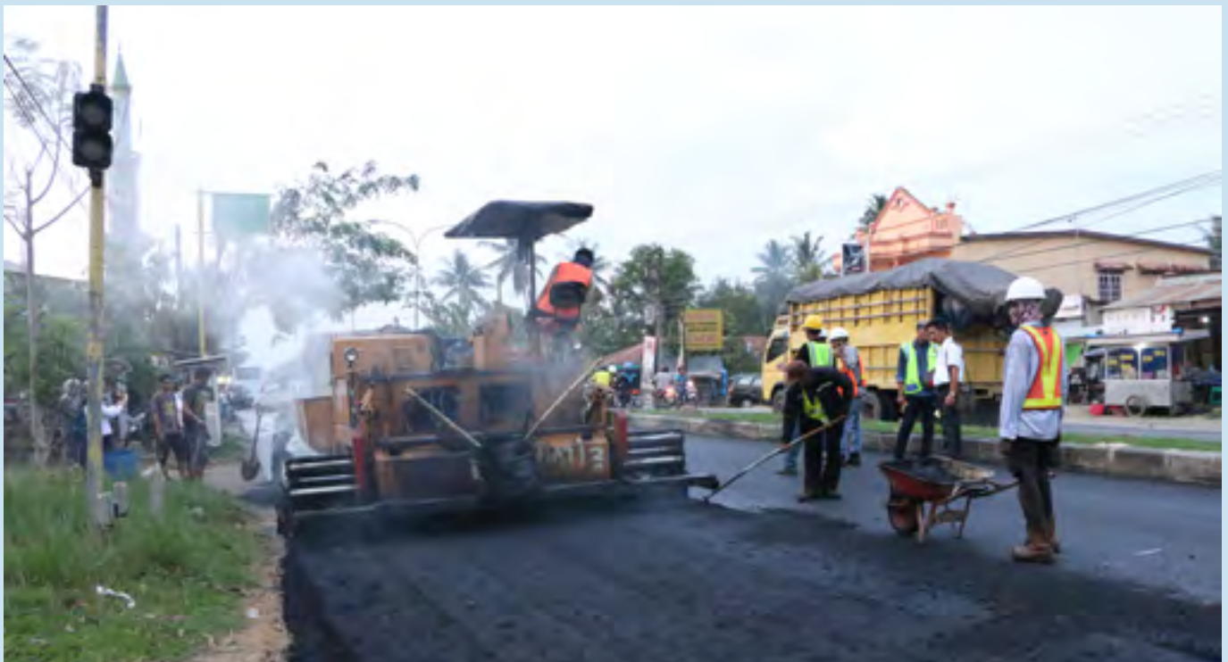
Pembangunan jalan dengan teknologi aspal plastik di Maros.
