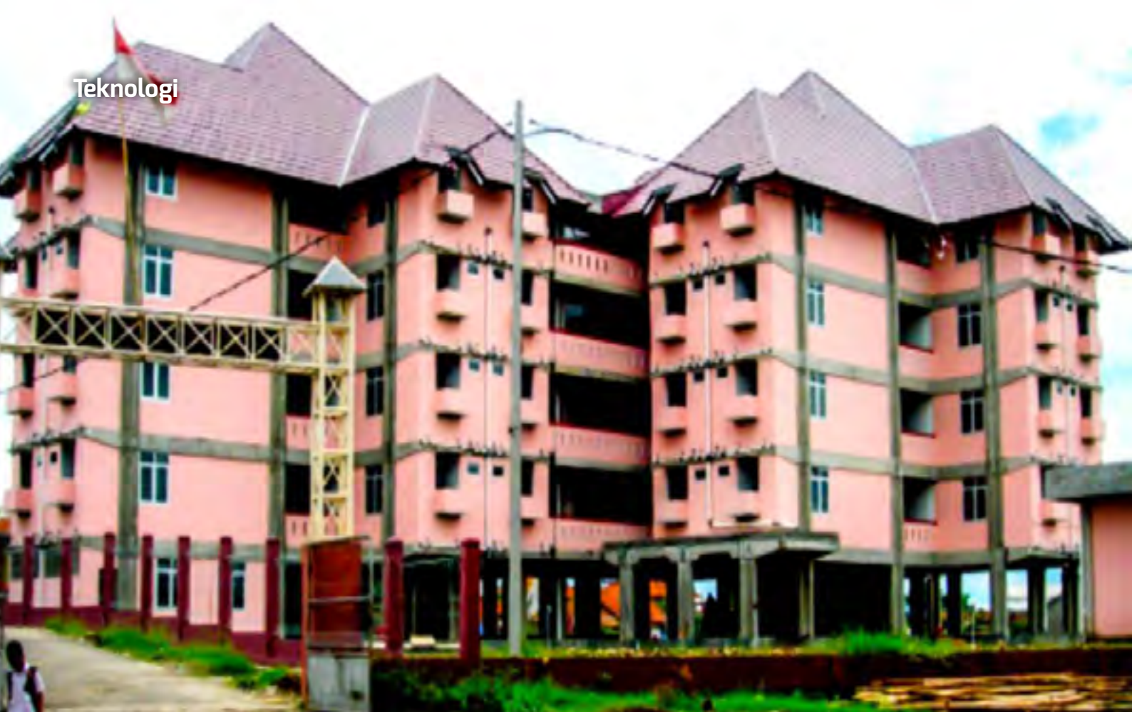
Rumah Susun Cigugur Tengah Kota Cimahi yang menerapkan Sistem Pracetak C-Plus
