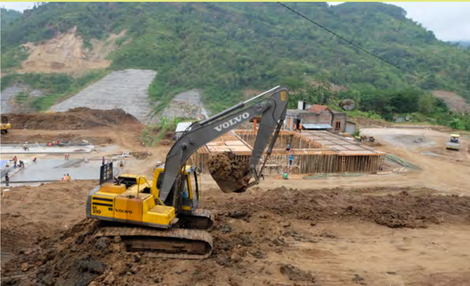
Pembangunan Anjungan Cerdas Trenggalek.
