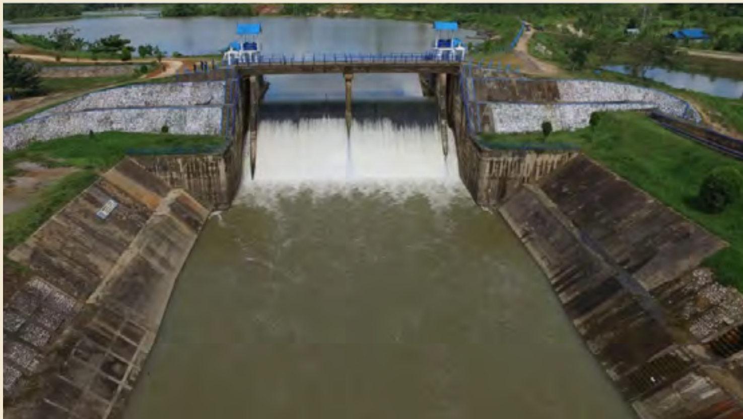
Bendungan Daerah Irigasi Karau Kalimantan Tengah
