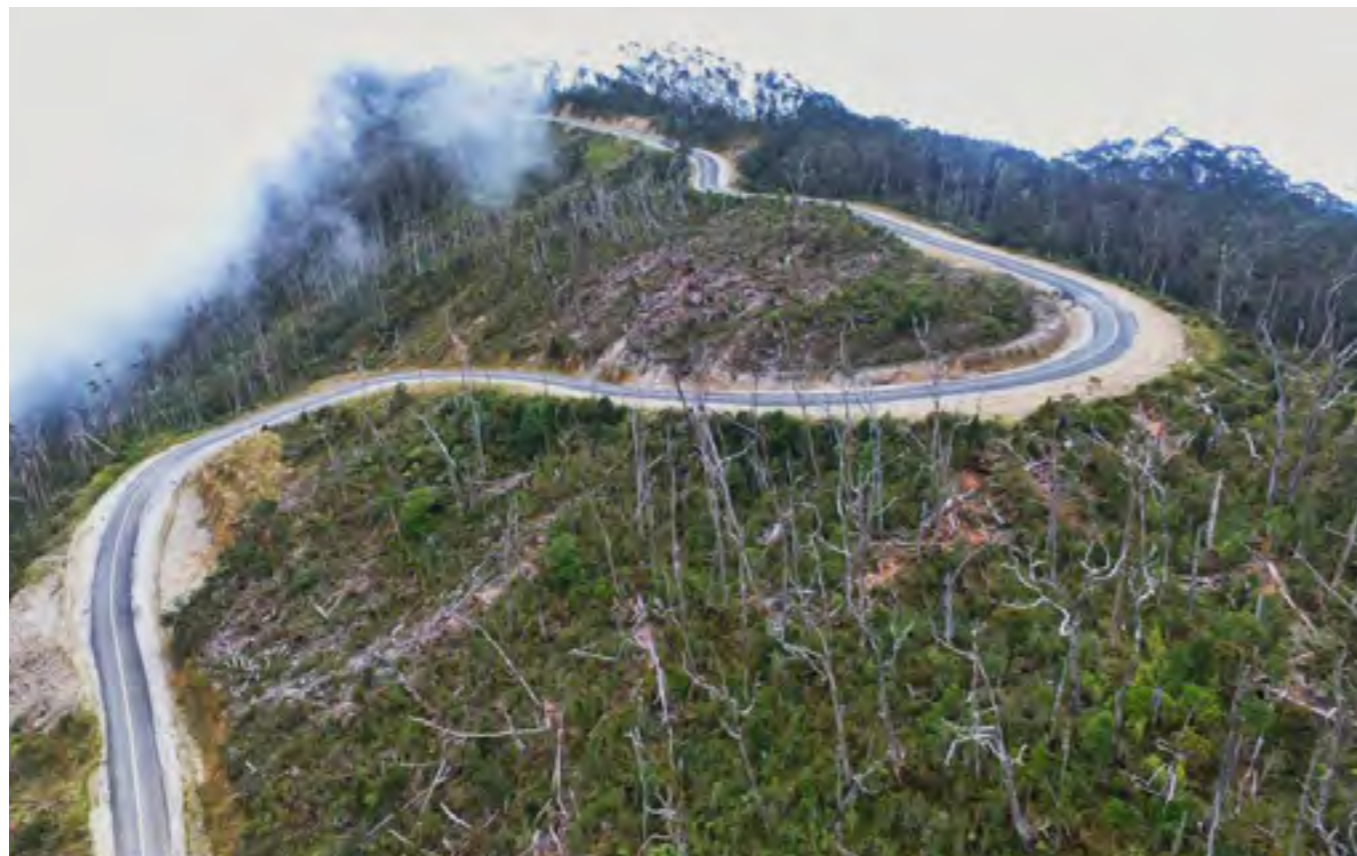
Pembangunan jalan Trans Papua
