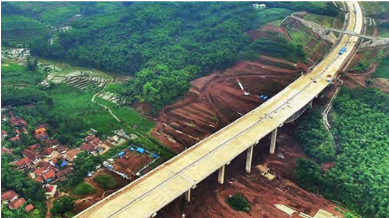
Pembangunan Jalan Tol Cileunyi-Sumedang-Dawuan (Cisumdawu) di Jawa Barat
