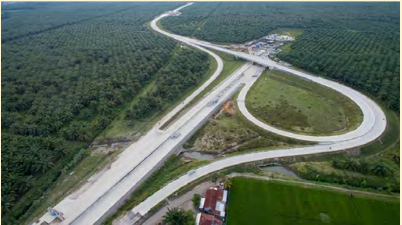
Pembangunan infrastruktur jalan Tol.
