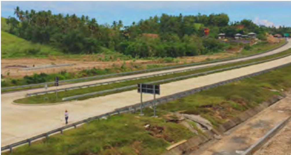
Sebagian Ruas Jalan Tol Manado-Bitung
