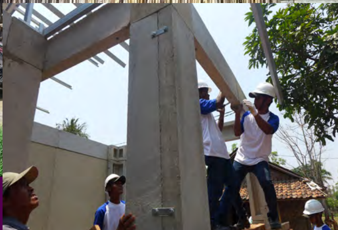
Model Rumah Instan Sederhana Sehat (RISHA), yang merupakan teknologi konstruksi sistem pracetak untuk bangunan sederhana
