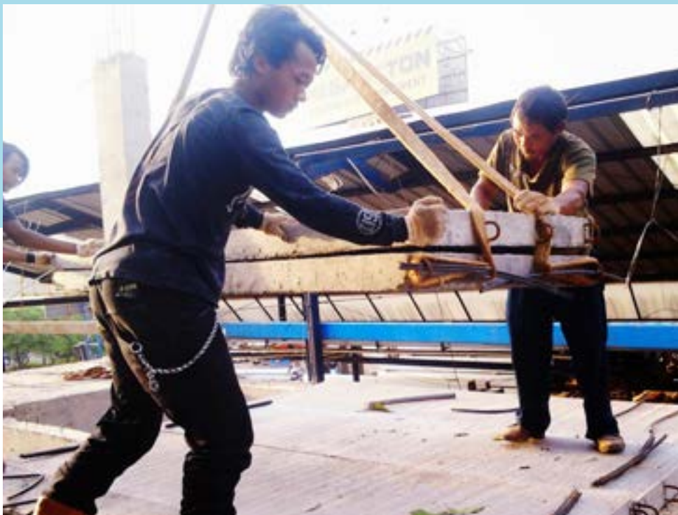
Proses Pengerjaan Flyslab pada Bangunan
