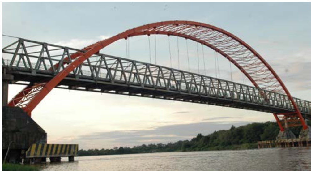
Jembatan Kahayan Palangkaraya
