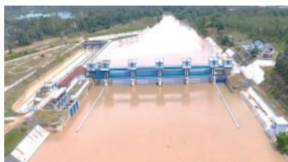
Gambar 4.6 Bendungan Gerak Jabung
