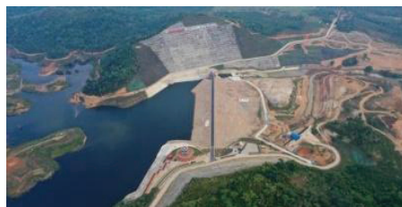
Gambar 4.4 Bendungan Way Sekampung
